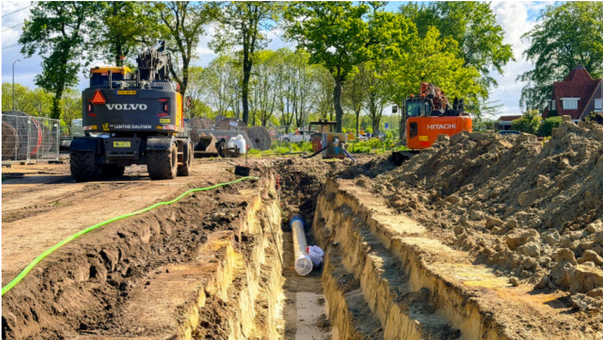
Foto: er wordt hard gewerkt aan de aanleg van een transportleiding vanaf de locatie Hoogeveen naar de locatie Beilen
